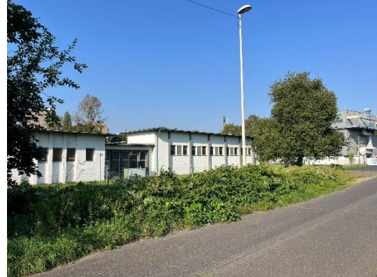
Abbildung 15: Bereich H liegt neben der Bahn direkt am geteilten Geh- und Radweg zwischen Mehlem Bf. und Mehlem Friedhof. Bäume spenden hier Fußgängern und Radfahrern Schatten.
