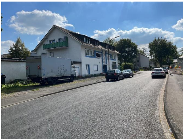
Abbildung 14: Bereich I liegt am Übergang der Honnefer Straße zur Antoniterstraße, in unmittelbarer Nähe zum Spielplatz kann hier eine Lücke im Grün geschlossen werden.
